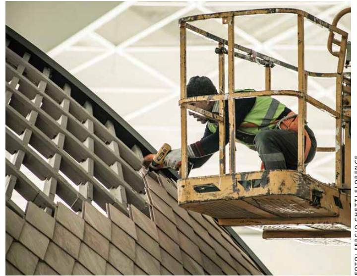
De Amerikanen wit eiken finereren overlappen het tussenliggende berkentriplex en elkaar, zodat een rijk geschubd uiterlijk ontstaat.
